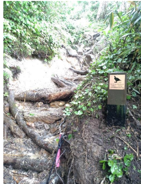
写真 27 近自然工法による登山道整備
